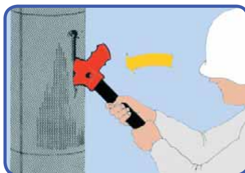
8. Tunn isoleringsplåt - pikeggen.
